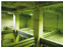
下水道処理ポンプ場耐震補強
