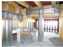
木造の五重塔の耐震補強
